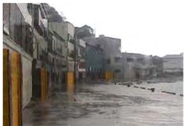
2001 年 9 月 11 日台風第 15 号による波浮港内の冠水
