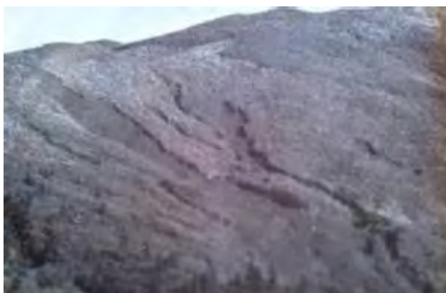
崩落した大金沢上流域の外輪山斜面
