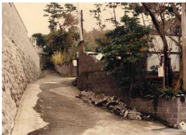
伊豆大島近海地震によるブロック塀の倒壊
